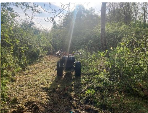
Débroussaillage et mise en place d'une nouvelle clôture.
