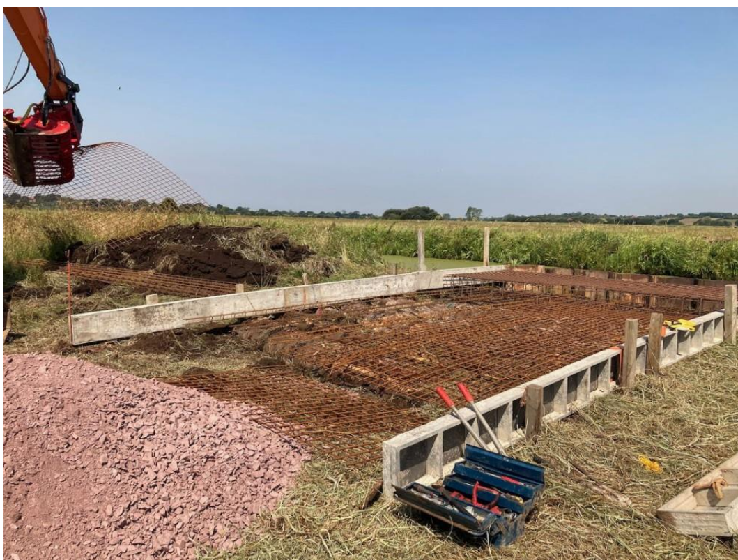
Construction d'un nouveau pont : réserve des marais de la Taute (photographie Alain Chartier)
