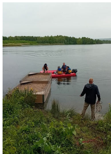
Chargement des radeaux en gravier puis traction vers le large. Radeaux mis en place Photographies Céline Chartier
