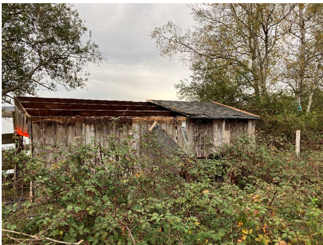
Démontage des toits des observatoires. Photographie Céline Chartier.
