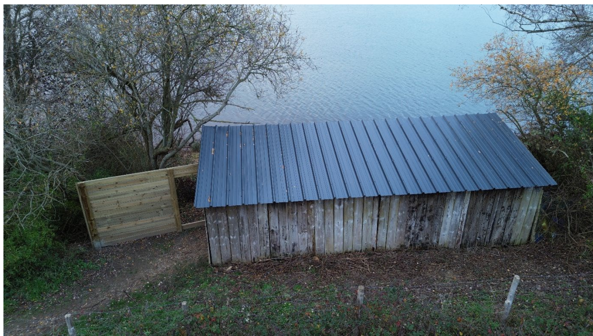
Nouveau toit. Photographie Céline Chartier.
